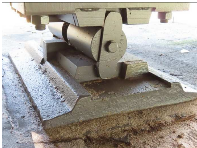
Foto č. 1 – K 01, chybějící zářka směrem k závěrné zdi
