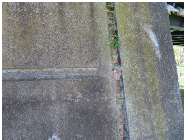
Foto č. 6 – O 02, křídlo vlevo, rozevření pracovní spáry a cihelná výplň
