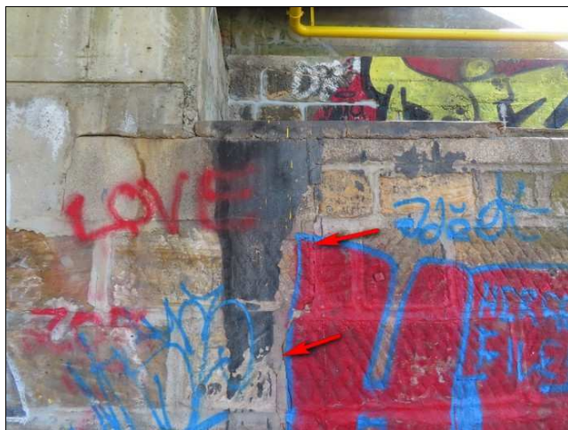
Foto č. 5 – O 02, svislá trhлина v prodloužené části ve vzdálenosti 0,60 m od hrany úl. prahu.
