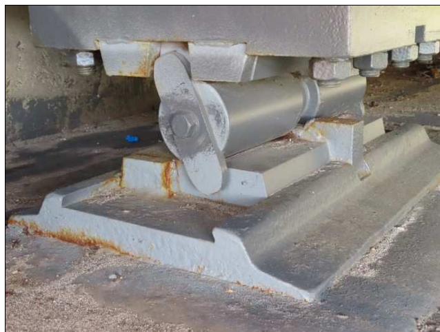
Foto č. 2 – K 01, chybějící zářka směrem do otvoru, sešikmení ložiska vpravo.
