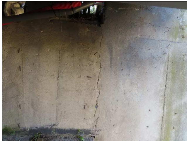
Foto č. 4 – O 01, svislá trhlina v závěrné zdi vlevo.
