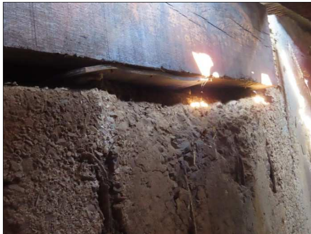
Foto č. 3 – O 01, degradace betonu závěrné zdi pod pozednicí
